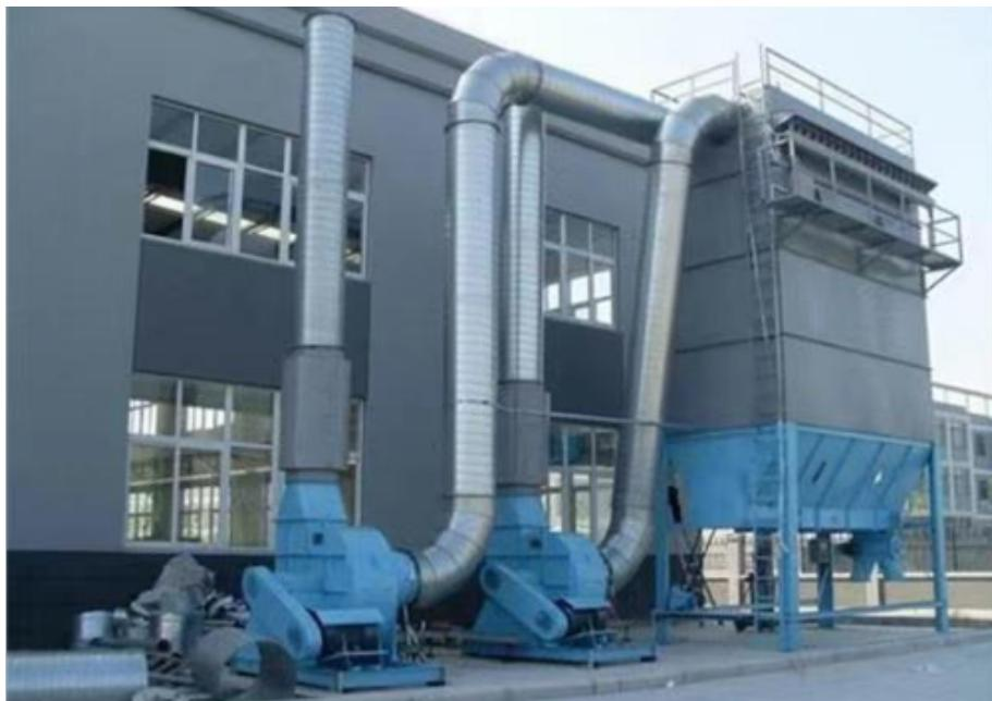
小型箱式脉冲喷吹除尘器。箱式喷吹是一个滤袋室用一个脉冲阀喷吹，不设喷吹管，一台除尘器分为若干个滤袋室，装设与袋室匹配的若干和脉冲阀，箱式喷吹脉冲除尘器的较大优点是喷吹装置简单，换袋维修方便。但是单室滤袋数量受限制。如果滤袋数量过多，会影响滤袋的清灰效果。喷吹脉冲除尘器的特点是在同一除尘室，各排滤袋轮流喷吹清灰，而且清灰是除尘过滤照样进行，即所谓在线清灰，这种清灰方式吹下的粉尘有部分会被临近的滤袋再次补集。如果用于捕集含尘浓度较大的气体，这种现象更为严重，所以喷吹脉冲除尘器受到一定的限制。气箱脉冲除尘器的特点是采用分时轮流进行清灰，即所谓离线清灰。当某一室进行喷吹清灰时，过滤气流被切断，避免了清灰产生粉尘二次飞扬。所以气箱式脉冲除尘器能捕集含尘浓度高达 $1000/m^3$ (标)的气体。
